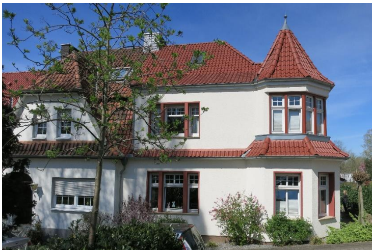
Turm am Gebäude Karolinenhöhe 2 Fotos: PLANUNGSBÜRO FLASPÖHLER
