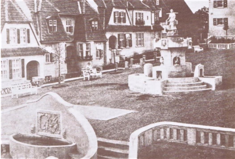
Historische Aufnahme vom „Marktplatz“ der Siedlung Karolinenhöhe mit dem Brunnen und der sogenannten Grotte 1
