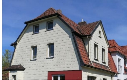
Mansardendach mit Krüppelwalm und Dachaufbau mit Giebelgaube
