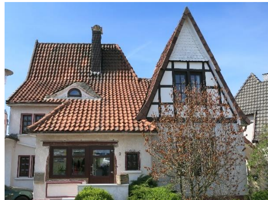
Zusammengesetztes Dach und Fledermausgaube
