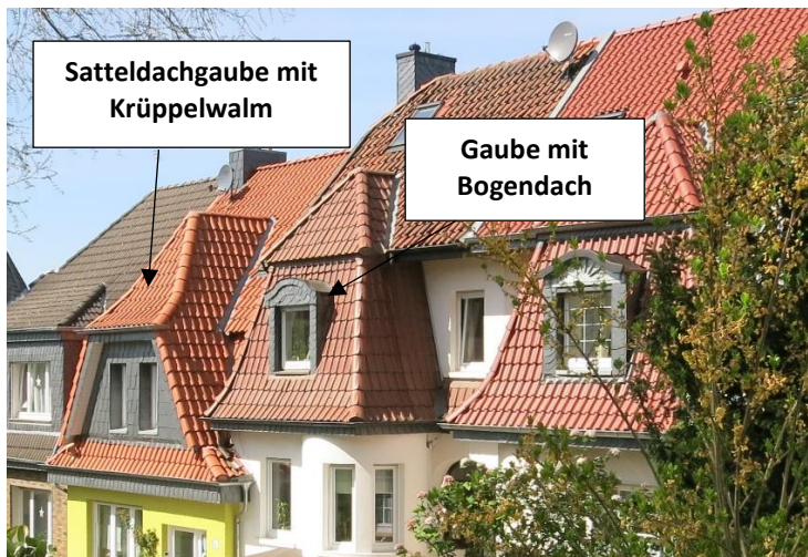
Verschiedene Dachgauben und Dachaufbauten
