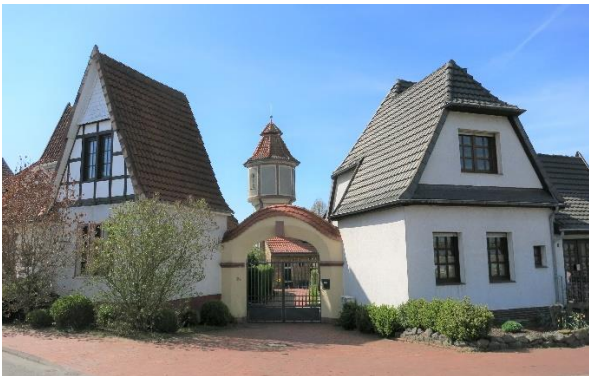
Torgebäude an der Zuwegung zum Wasserturm
